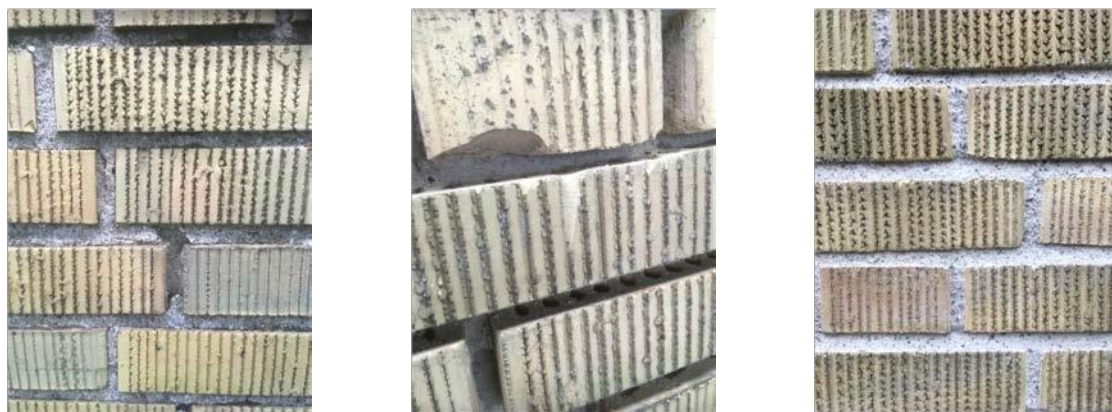
Bild 1. Tegelfasad från 1950-talet; före (vänster), under (mitten) och efter (höger) omfogning.
